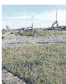
CASTELMASSA I lavori nel rondò
