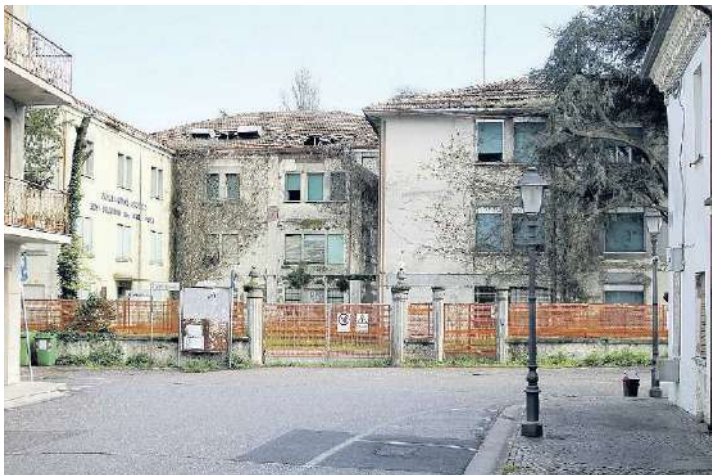
EX OSPEDALE La struttura è chiusa ormai da 27 anni e sarebbe frequentata malgrado i pericoli
